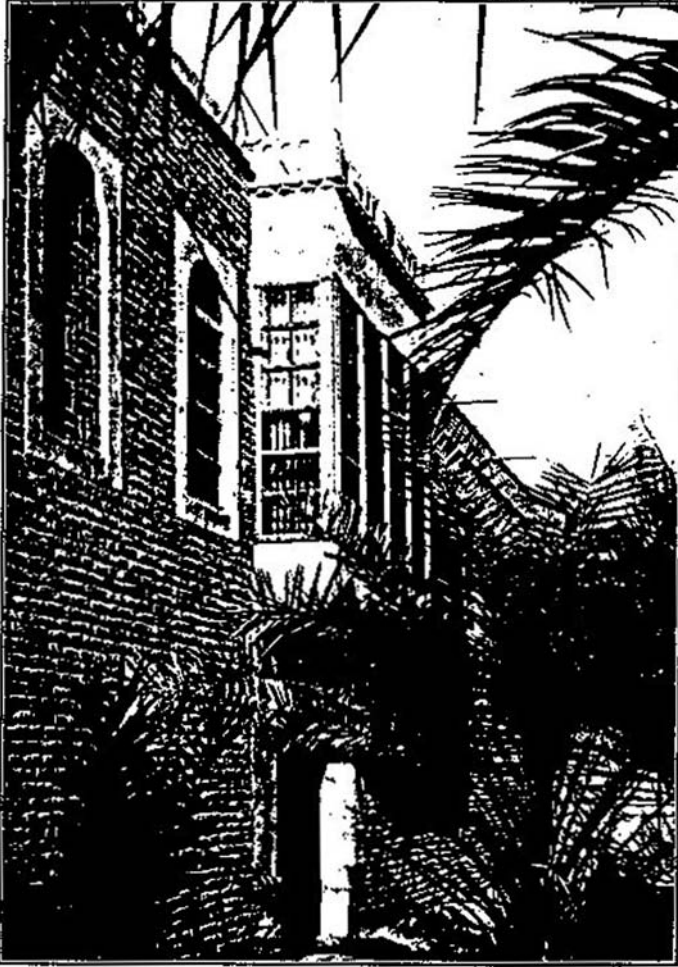
Fig. 84. Haus von antikem Ziegelmaterial; Erkervorbau; Blindfenster-, Fenster- und Türumrahmungen, Sinsglieder und Dachbalustrade mit Gips verputzt.
